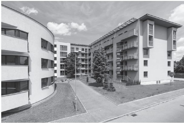
Rys. 4. Trzy budynki mieszkalne wielorodzinne z garażami podziemnymi w Krakowie
