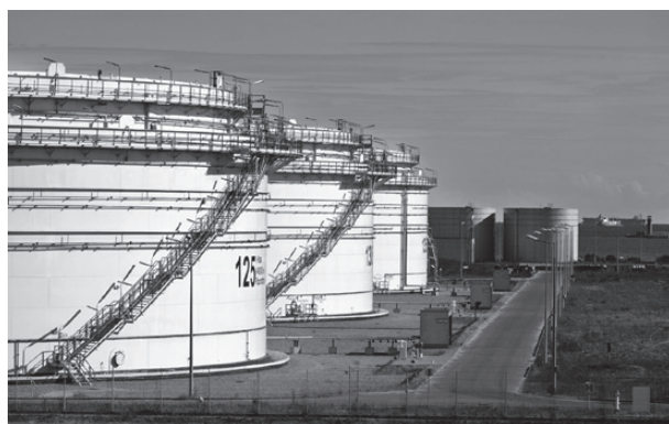
Rys. 10. Terminal Naftowy w Gdańsku
