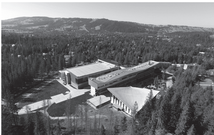
Rys. 5. Budowa hali sportowej wielofunkcyjnej wraz z infrastrukturą towarzyszącą w Centralnym Ośrodku Sportu – Ośrodku Przygotowań Olimpijskich w Zakopanem
