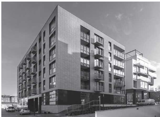
Rys. 2. Wielorodzinny budynek mieszkalno-usługowy z instalacjami wewnętrznymi w ramach IV etapu realizacji zespołu mieszkaniowego „Sadowa” w Gdańsku
