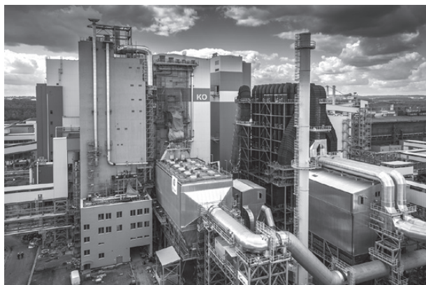
Rys. 11. Zabudowa konstrukcji kompleksu hal pieca zawieszinowego i pieca elektrycznego, kotła odzysknicowego, budynku elektryczno-energetycznego, rozbudowa hali pieca anodowego wraz z konstrukcją pod urządzenia oraz instalacjami, realizowane w ramach programu modernizacji pirometalurgii w Hucie Miedzi Głogów
